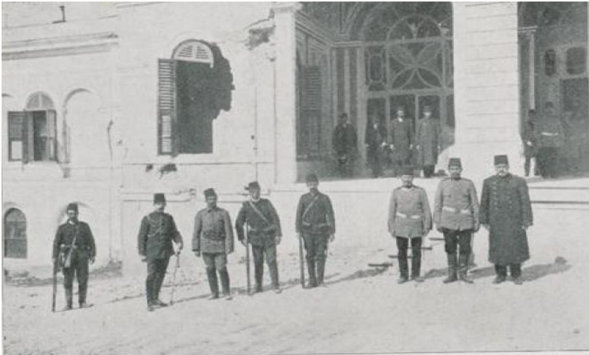
Görsel 73. Bâbüâli'nin Yâver Dairesi'nde top mermisinin açtığı hasar (Şehbâl, 1909b, s. 95).
