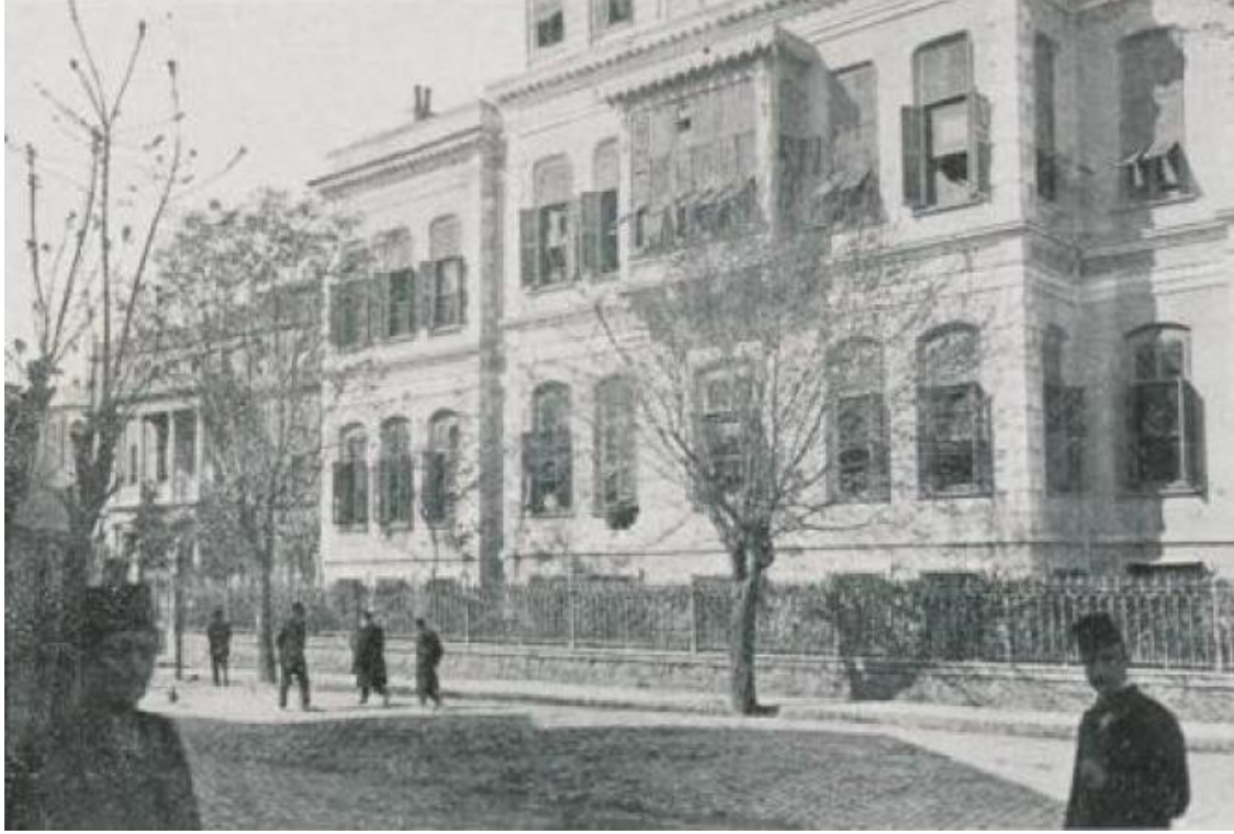
Görsel 74. Nâfia Nezâreti binasında top ateşinin yol açtığı tahribat ( Şehbâl , 1909b, s. 95).
